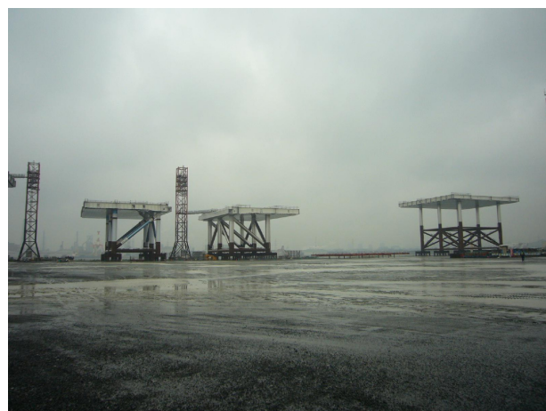
図2 ジャケット建造現場の様子（見学会途中）
